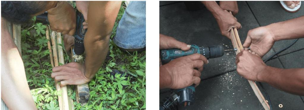
Gambar 3. Sambungan bambu menggunakan baut
