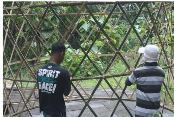
Gambar 2. Pengaplikasian Bambu untuk Struktur dan juga dinding
